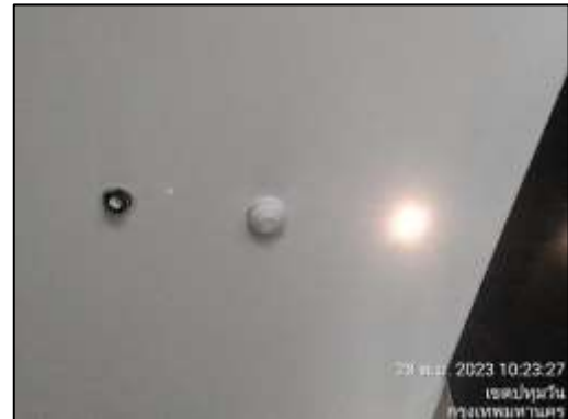
รูปที่ 42 (ต่อ) อุปกรณ์ตรวจจับควัน ตรวจจับความร้อน
