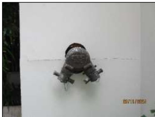
รูปที่ 47 หัวรับและจ่ายน้ำดับเพลิง
