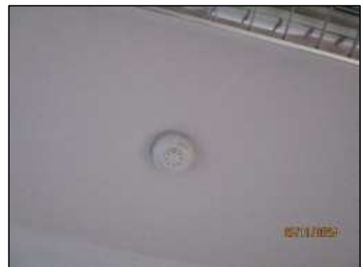
รูปที่ 42 อุปกรณ์ตรวจจับควัน ตรวจจับความร้อน
