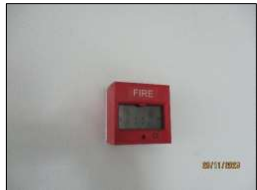
รูปที่ 41 ชุดกดแจ้งเหตุ และกระดิ่งแจ้งสัญญาณเพลิงไหม้
