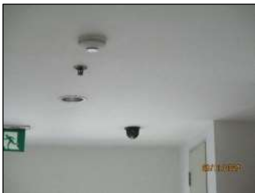
รูปที่ 42 อุปกรณ์ตรวจจับควัน ตรวจจับความร้อน
