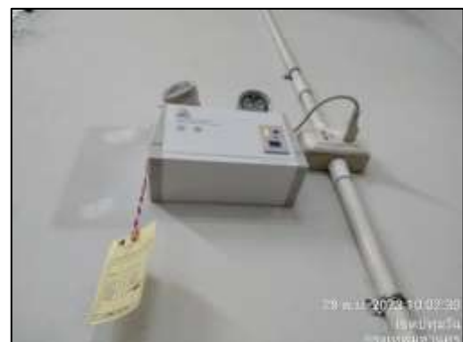
รูปที่ 43 ระบบไฟสำรองฉุกเฉิน
