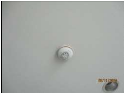
รูปที่ 42 (ต่อ) อุปกรณ์ตรวจจับควัน ตรวจจับความร้อน
