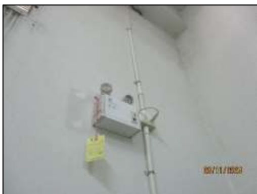
รูปที่ 43 ระบบไฟสำรองฉุกเฉิน
